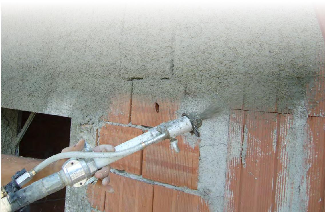
Intonaco termoisolante fibrorinforzato a base di perle vergini di polistirene espanso Neopor®, conforme ai CRITERI AMBIENTALI MINIMI (CAM)
