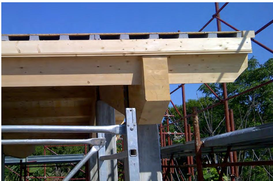
Sistema di isolamento termico ventilato di coperture a falde con pannello stampato in Neopor® (EPS additivato con grafite, ottenuto da materie prime rinnovabili derivate da biomassa) accoppiato a OSB tipo 3 da 13 mm.
