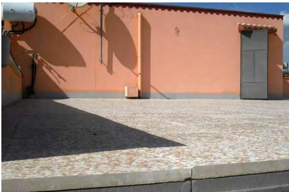
Sistema di isolamento termico orizzontale stampato in Neopor® (EPS additivato con grafite) rivestito da lastra in cemento armata nel getto da 30 mm
