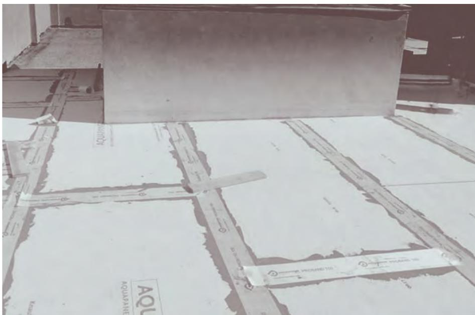
Sistema di isolamento termico in Neopor® (EPS additivato con grafite) accoppiato a pannello Aquapanel® Cement Board da 12,5 mm.
