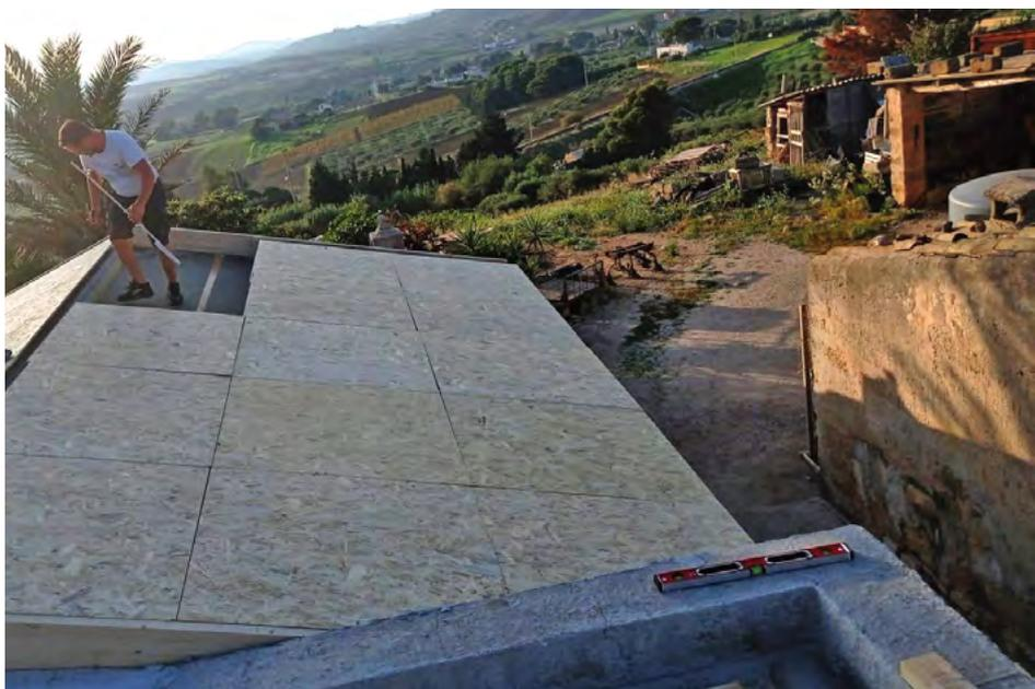
Sistema di isolamento termo-acustico ventilato di coperture a falde con pannello stampato in Neopor® accoppiato a OSB tipo 3 da 13 mm e a pannello di lana di roccia da 50 mm all'intradosso.
