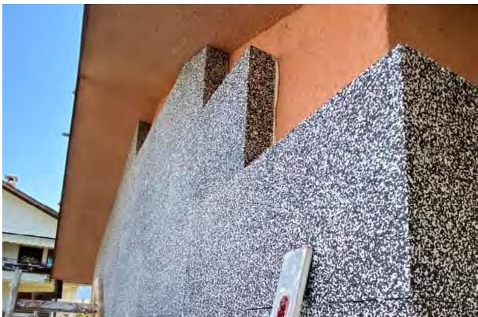
Lastra tagliata da blocco Styropor® e Neopor® (EPS additivato con grafite) a bordo dritto per isolamento termico a cappotto.
