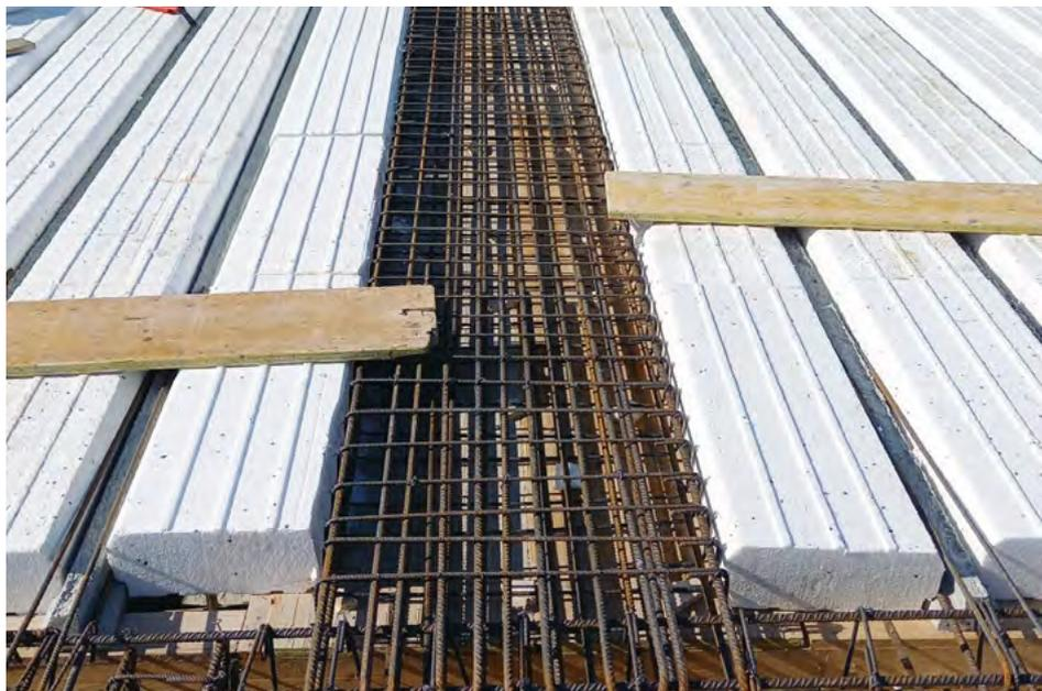
Pignatta autoestinguente in EPS per solai alleggeriti con dentello sagomato per travetto precompresso (PORONTEP) o per travetto tralicciato (PORONTEP L).
